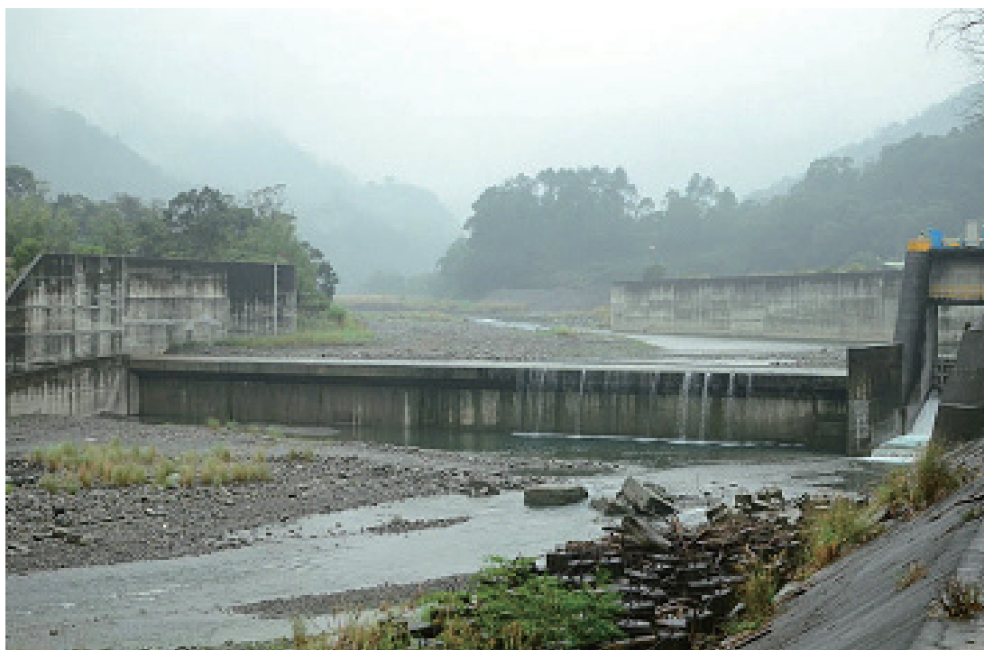
▲軟橋發電所之攔河堰。
