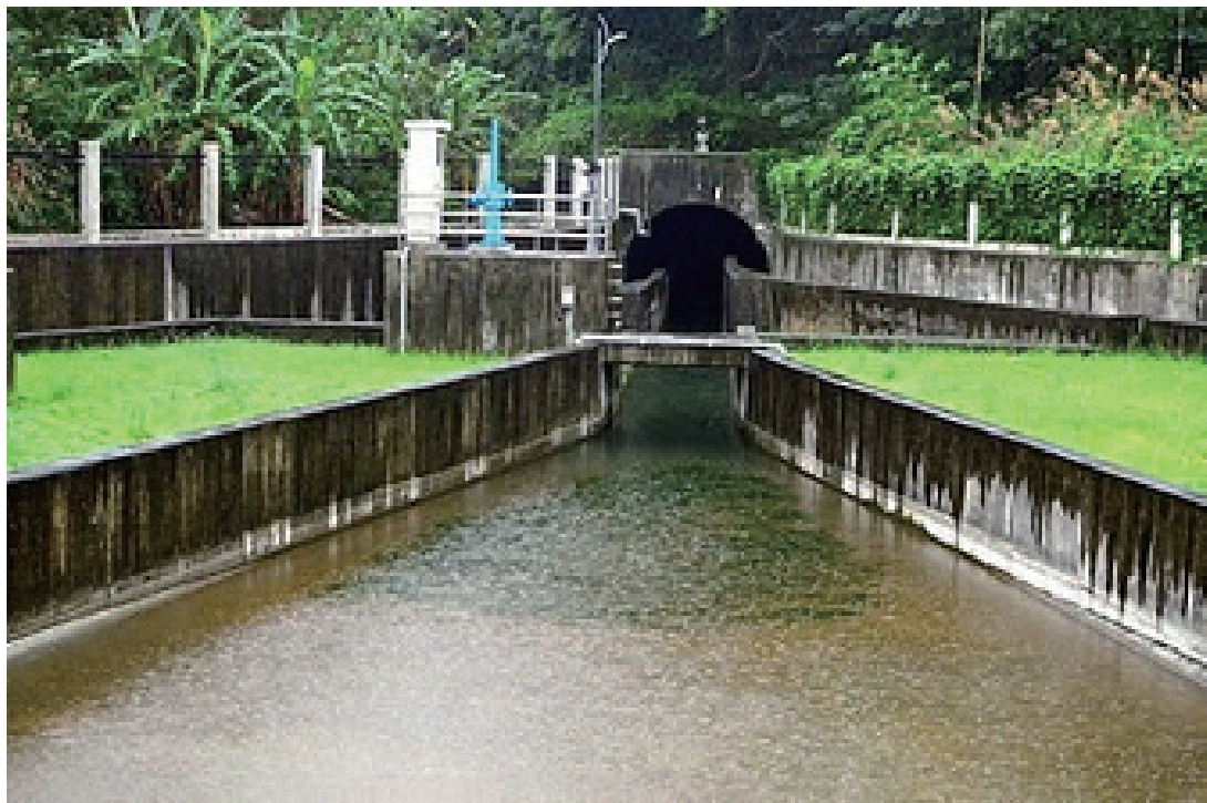
▲軟橋發電所進水口寫真。
