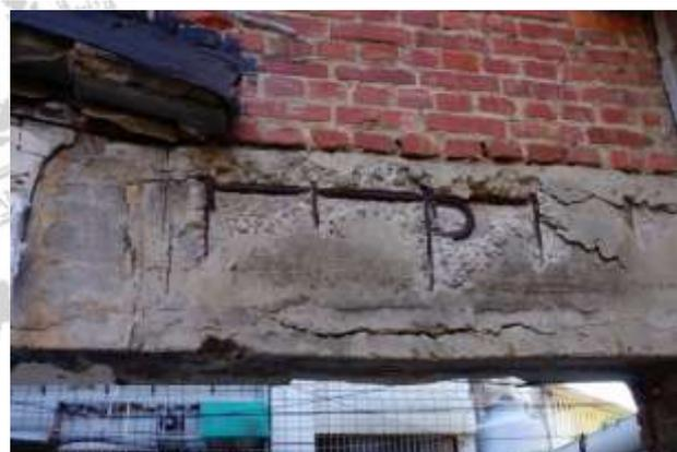
毀損的鋼筋混凝土梁，露出無節鋼筋
