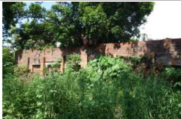
單純磚造的牆面，有磚造扶壁柱加強
