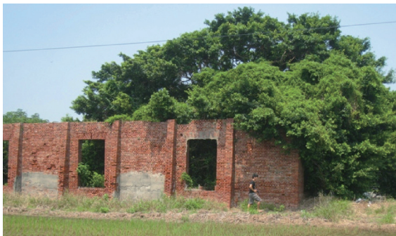
照片 4 新高廠現存未完成廠房
