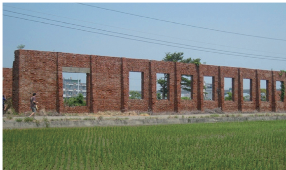
照片 5 新高廠現存未完成廠房
